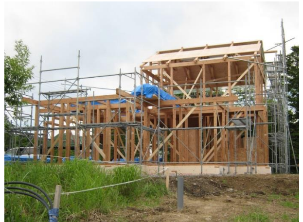
写真4 カラマツを構造材とした住宅例
