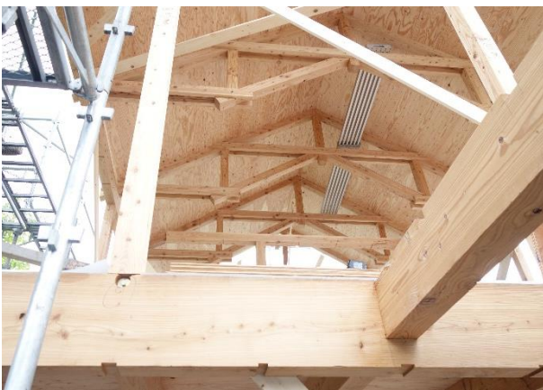
写真3 コアドライの要領に基づいて生産した平角材の施工例（上から プレカット材，建て方，梁材と小屋組）
