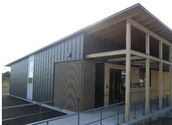
北斗市道営住宅集会所
