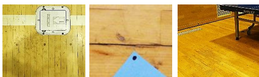
図3 支柱差し込み 図4 収縮による 図5 卓球使用に 穴周辺の凹み 目地の割れ 伴う塗装剥がれ
