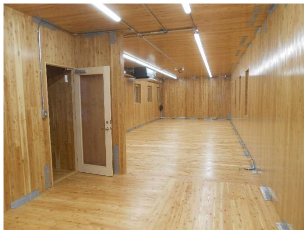
写真3 CLTで“あらかし”仕様とした内観
