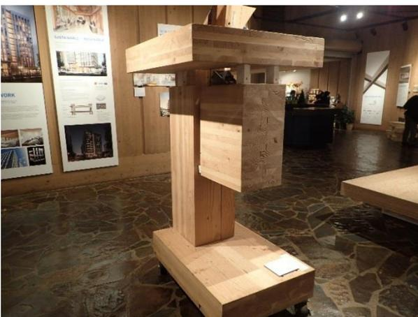
写真3 耐震性を考慮したCLTの接合
