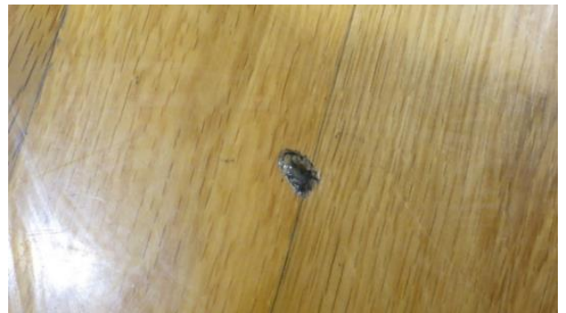
写真27 基材が露出した凹みを塗装する
