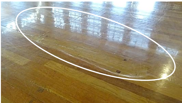
写真7 移動式バスケットゴールによる凹み
