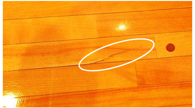
写真25 割れの引っかけりを塗装する
