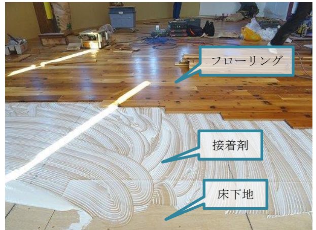
写真7 フローリングの止め付け施工
