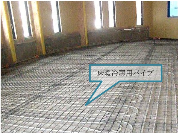
写真5 床暖冷房用パイプの敷設状況
