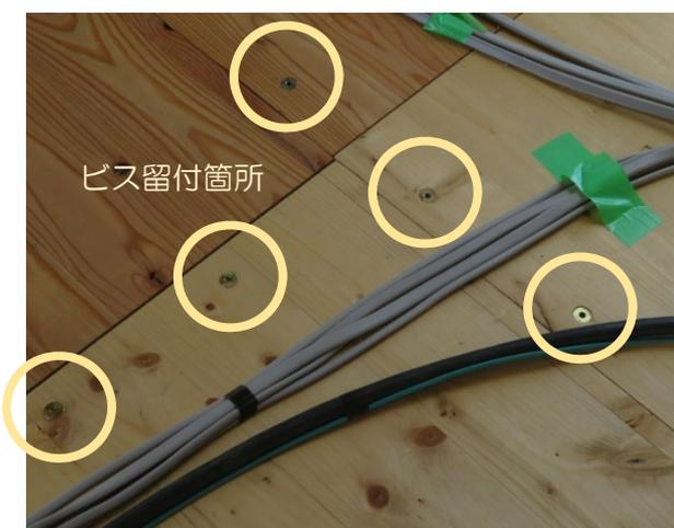
写真7 床パネルのビス留め付け状況
