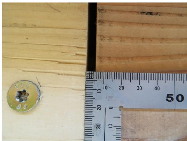
写真8 床パネルジョイント部の隙間
