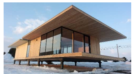
図4 実験棟の外観
