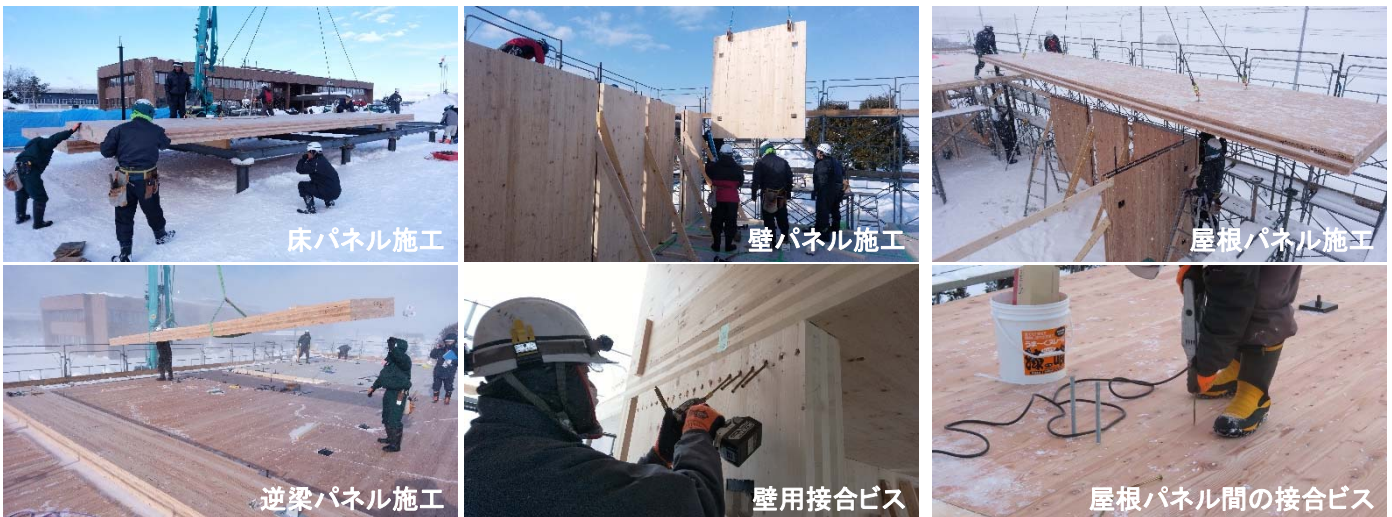
図3 各工程の作業の様子
