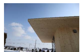
図4 道産CLTを活かした設計例 (軒の出を大きくした屋根)
