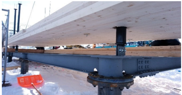
写真7 鉄骨円柱と床パネルの納まり
