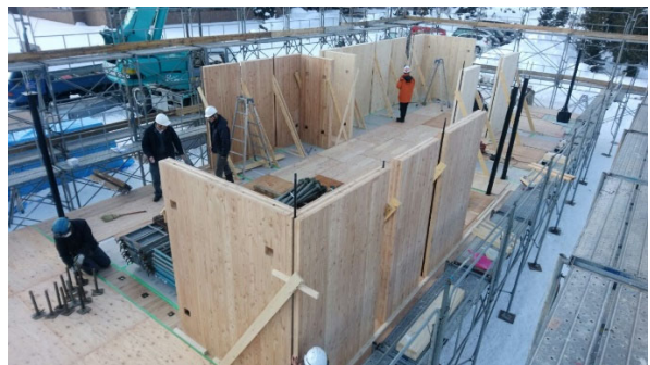
写真8 壁パネルの施工
