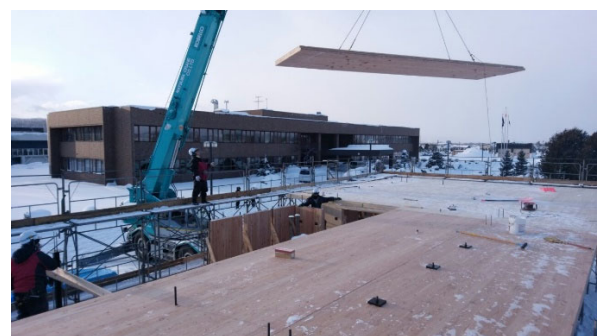
写真9 屋根パネルの施工
