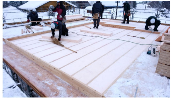
写真21 屋根パネル上の外断熱施工
