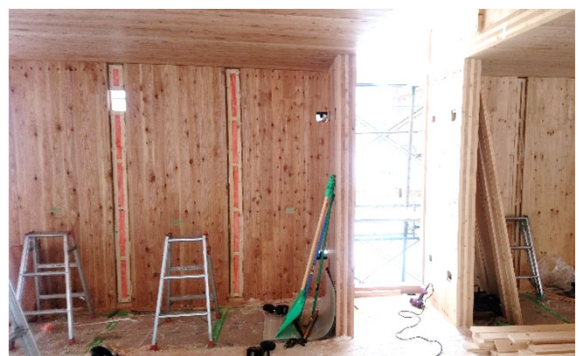
写真23 壁パネル間の断熱気密施工
