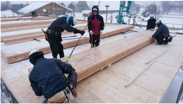
写真11 屋根上の逆梁パネルの施工
