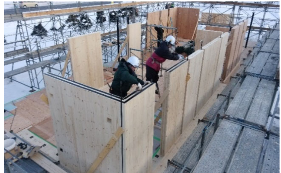
写真22 壁パネル上部の気密施工
