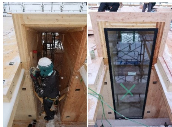
写真24 CLT躯体の切り欠きに直接はめ込んだガラス
