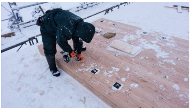
写真12 逆梁パネルと屋根パネルのボルト接合
