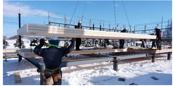
写真6 床パネルの施工
