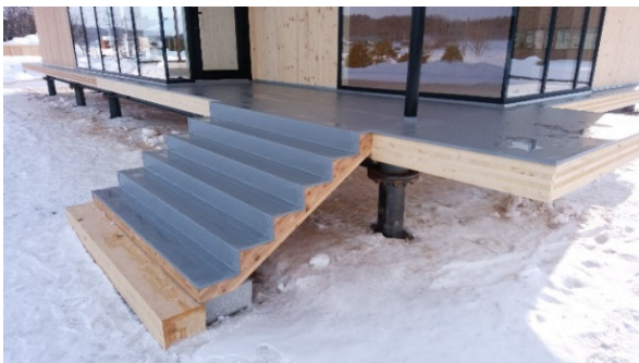
写真25 屋根面と屋外床面の防水工事
