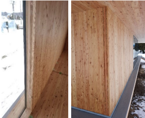
写真20 屋内外で“現し”とした外壁CLT
