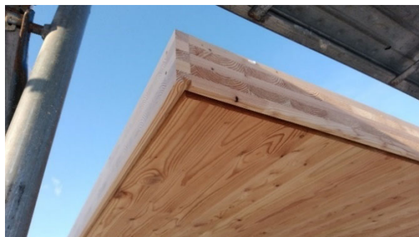
写真26 パネル木口に取り付けた被覆板
