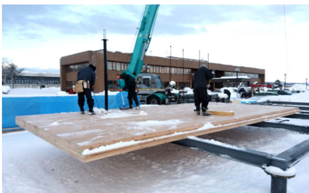
写真13 床パネルと連続的にはね出したテラス部
