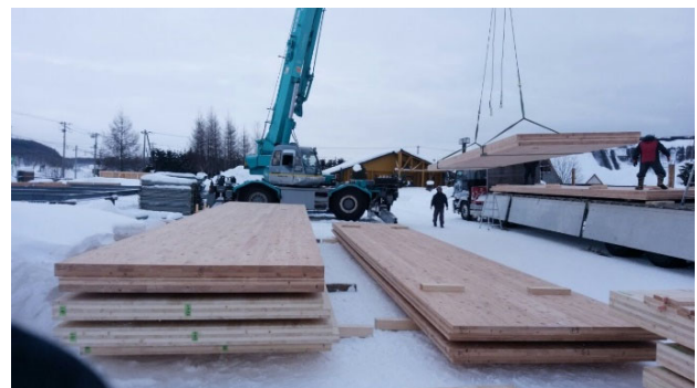
写真4 CLTパネルの荷下ろし
