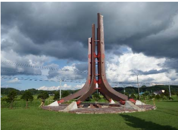
図2 解体前シンボルタワー外観（2017年）
