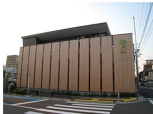
写真1 LVLを用いた仮囲い（上）と外壁（下）
