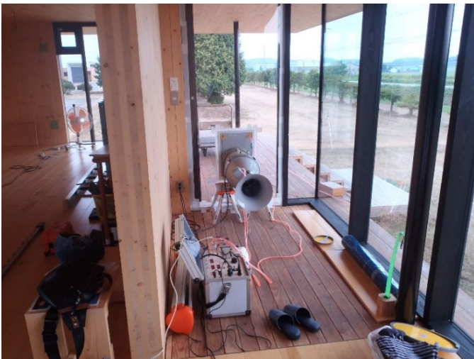
写真2 送風機設置状況
