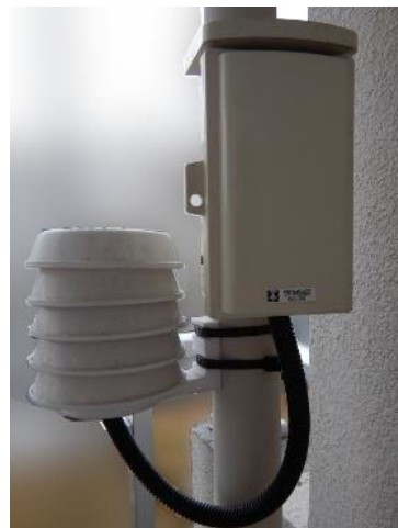
図5 ベランダへの設置状況
