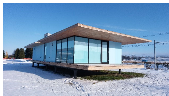
図3 壁パネルの付加断熱試験
