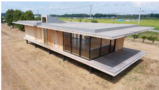
図1 CLT実験棟の現況
