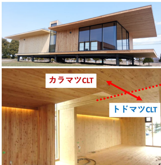
写真3 内外装現し仕様としたCLT実験棟の壁パネル
