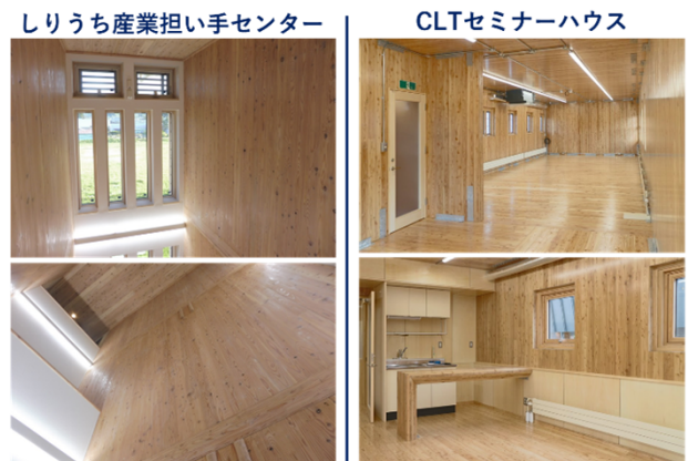
写真2 道内のCLT建築における内装現しの例
