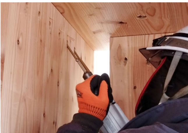
写真8 長ビス接合(壁-屋根接合部)
