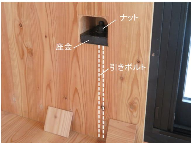
写真3 引きボルト接合
