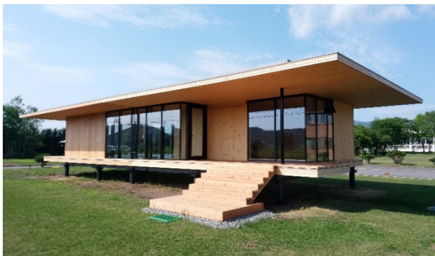
写真2 Hokkaido CLT Pavilion (CLT実験棟)
