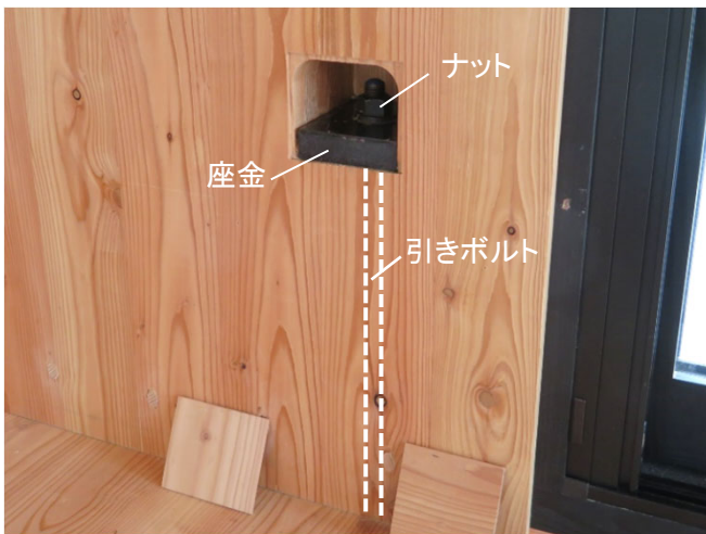
写真3 引きボルト接合
