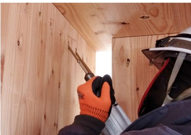
写真8 長ビス接合(壁-屋根接合部)
