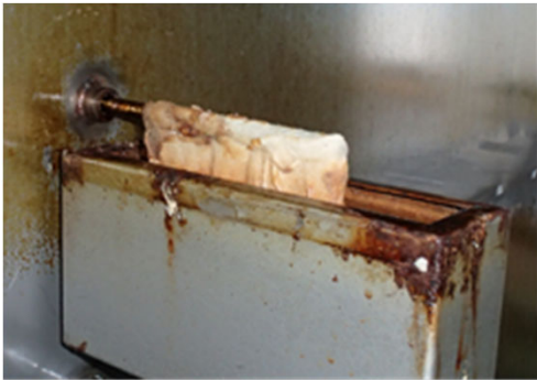
写真10 汚染した湿球センサーのガーゼ
