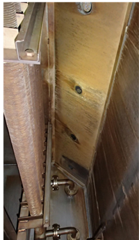
写真9 上部整流板の通気孔
