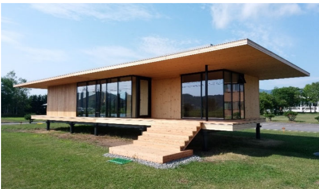
写真2 Hokkaido CLT Pavilion (CLT実験棟)
