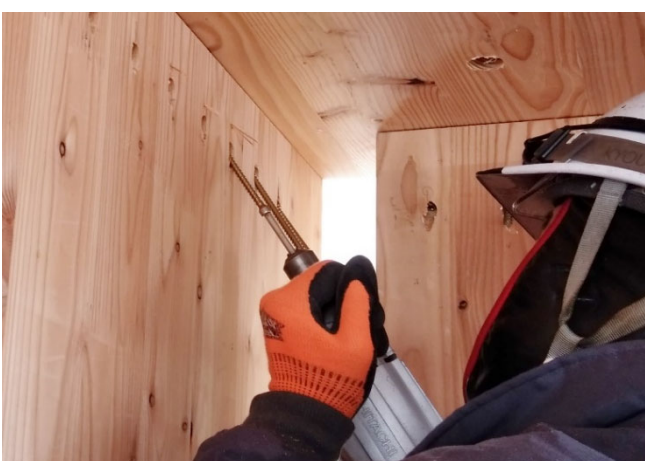
写真8 長ビス接合(壁-屋根接合部)
