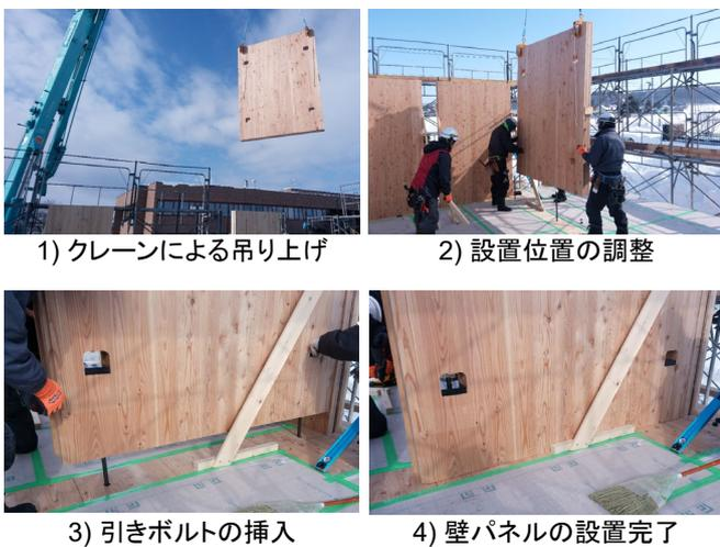
写真4 壁パネルの設置（引きボルト接合部）
