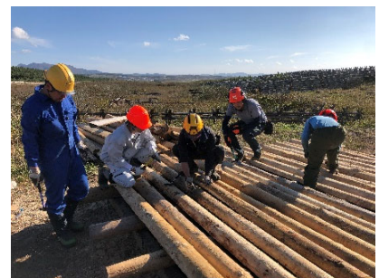
【防風柵の設置（檜山管内）】
