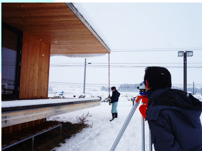
CLT実験棟屋根の積雪による変形の測定
