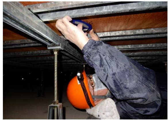
写真6 下地合板の含水率の測定
