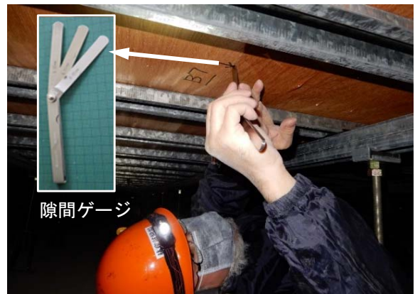
写真7 下地合板の目地幅の測定
