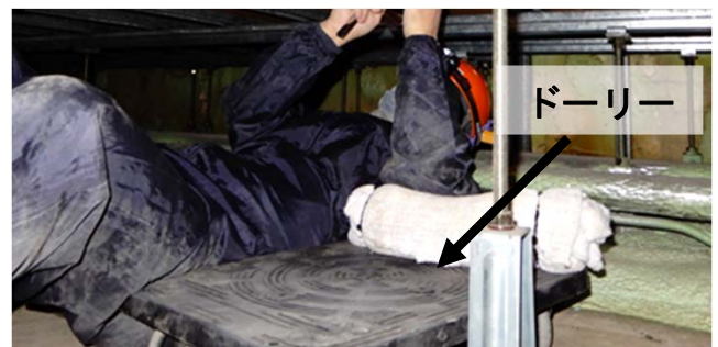
写真5 床下の測定風景とドーリー
