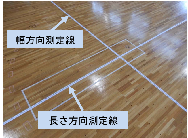
写真2 フローリングの測定線の例
