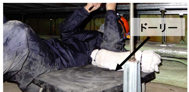
写真5 床下の測定風景とドーリー
