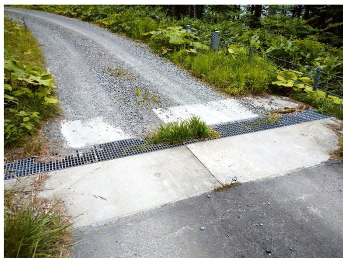
図3 コンクリート製横断排水溝の例
