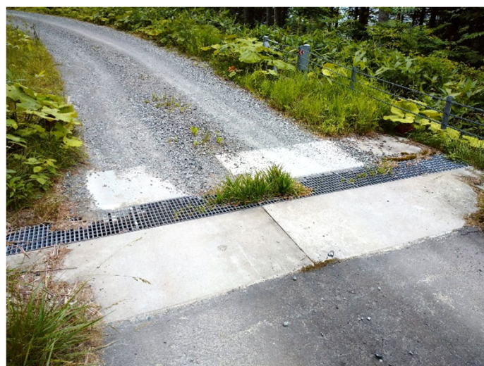
図3 コンクリート製横断排水溝の例
