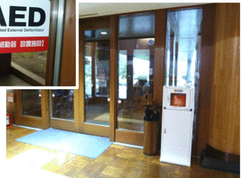
写真2 玄関横のAED設置状況 (林産試験場 広報担当)
