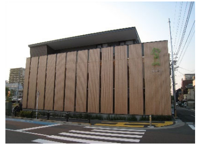
外装材として使用されたLVL
