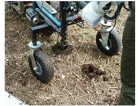
写真6 試験風景（池田町） ドリルによる穴開け
