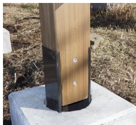
採用した「特殊穿孔ビス2本縦打ち」の施工の様子
