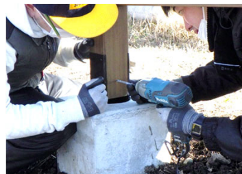
採用した「特殊穿孔ビス2本縦打ち」の施工の様子
