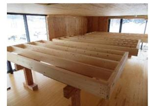
図8 床パネルの設置状況
