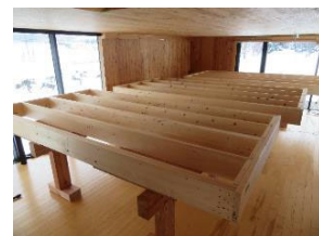
図8 床パネルの設置状況 (幅1.8m×長さ3.6m)
