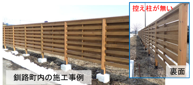
想定される最大風力に対して支柱の弾性変形で抵抗できるため控え柱を省略できました。
