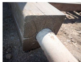
写真13 柱脚部の状態 (スギ)
