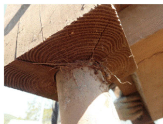
写真13 柱脚部の状態 (スギ)
