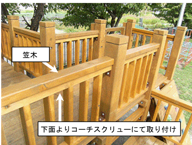
写真8 手すり横木上面に笠木の取り付け
