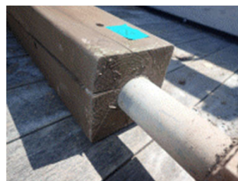
写真15 柱脚部の状態 (処理木材) (左:スギ, 右:トドマツ)
