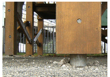
写真4 埋め戻し後の状態
