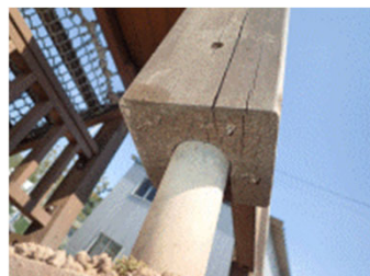
写真14 柱脚部の状態 (トドマツ)
