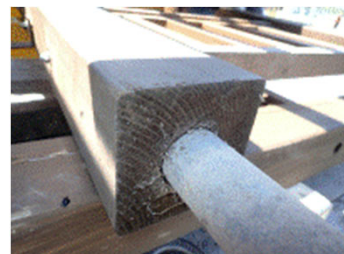
写真14 柱脚部の状態 (トドマツ)
