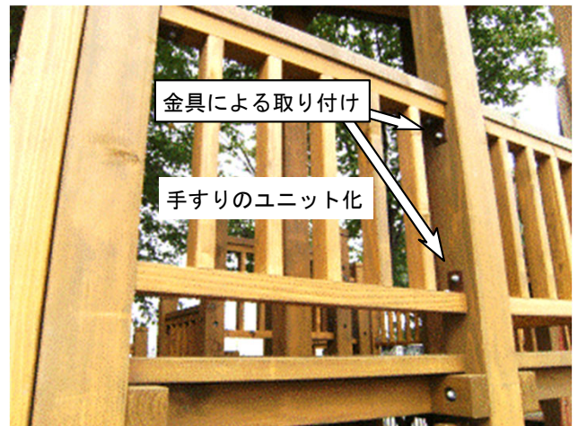
写真10 手すりのユニット化と金具による取り付け
