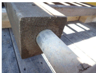
写真15 柱脚部の状態 (処理木材) (左:スギ, 右:トドマツ)
