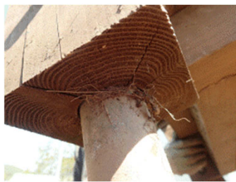
写真13 柱脚部の状態 (スギ)
