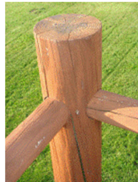
写真9 支柱の側面を切り欠いた横木の取り付け
