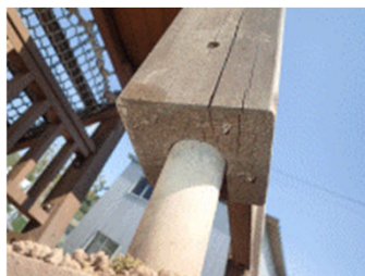
写真14 柱脚部の状態 (トドマツ)
