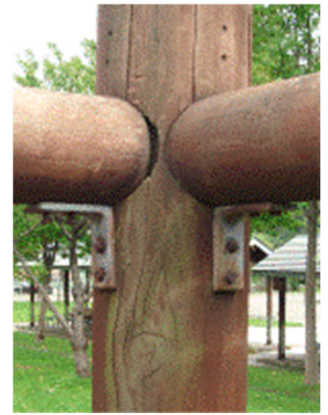
写真9 支柱の側面を切り欠いた横木の取り付け
