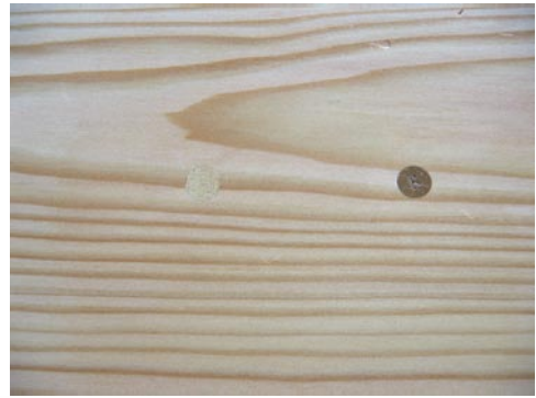
写真4 のみで削り，研磨紙掛け
