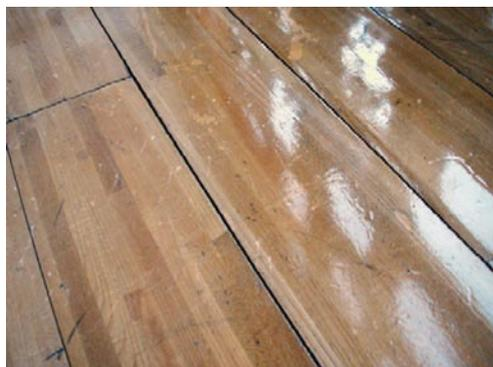
写真1 フローリングの合わせ目に生じたすき間
