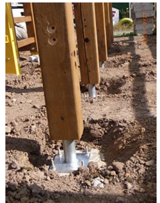
写真1 支柱脚部の金具
