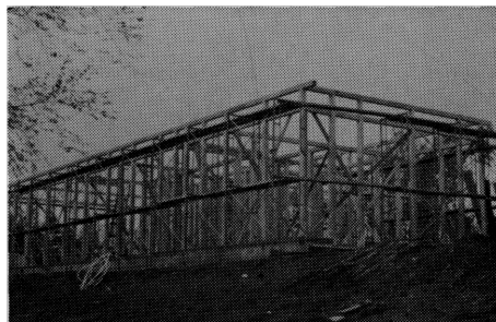
写真 - 2 カラマツ材による骨組み
