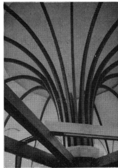
写真4 ドームの内部 （ラジアータパインの わん曲集成材）
