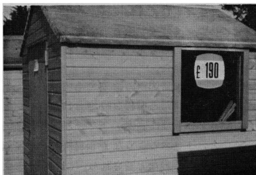
写真-4 木製物置(外装はすべて防腐処理してある)
