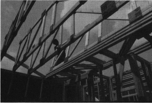
トラスの建て上り
