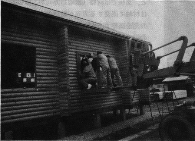
⑥ 木製窓の取り付け
