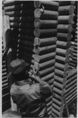
⑦ ドア開口部へ木片の釘打ち
