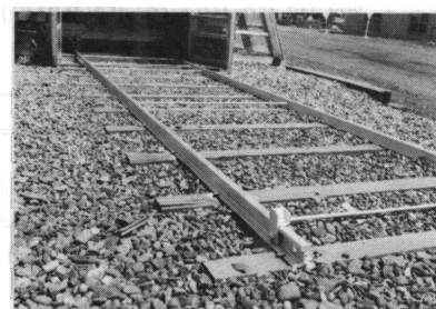
写真11 マクラ木とレール
