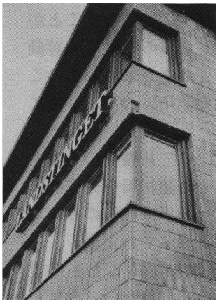
スウェーデンのイエープレでみた事務所建築の針葉樹の窓（壁はタイル打ち込みのコンクリート板）
