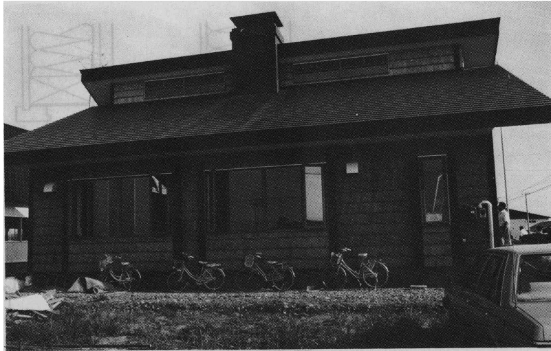
② 木製サッシ施工例 (士別市)
