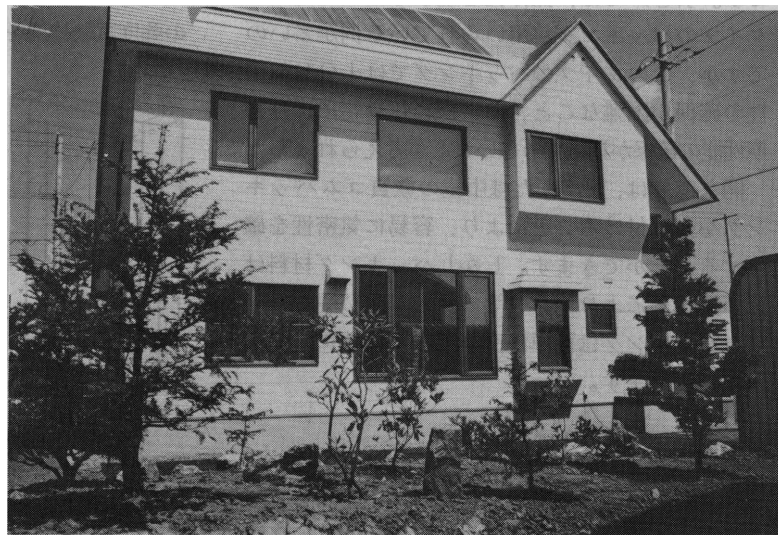
① 木製サッシ施工例 (旭川市)
