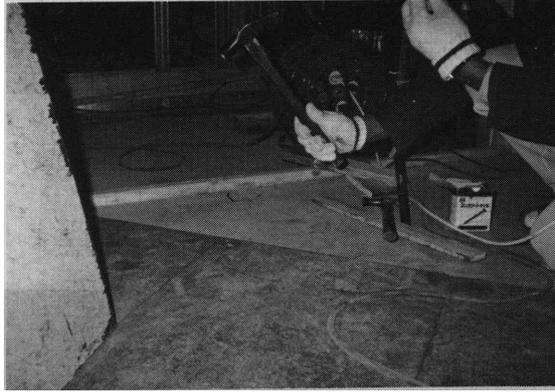
コンクリート床基礎に釘で直接張る
