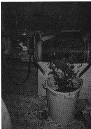
⑦ 混合機から混合物の供給
