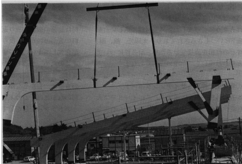
35tonクレーンによる集成材骨組の建て上げ風景
