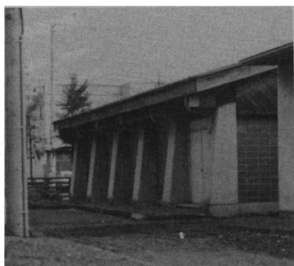
写真5 写真4の建物の背面側(RCの柱とブロックの壁が見える。)
