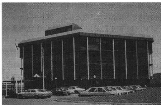
写真3 集成材4階建て構造物
