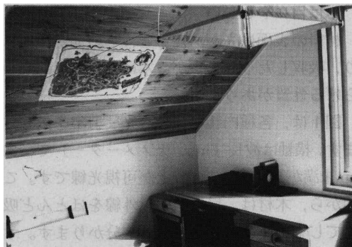
天井に張られたカラマツパネルボード
