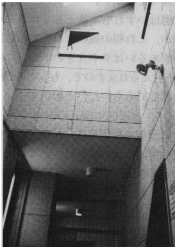
玄関の吹き抜け部に使われたカラマツセメントボード
