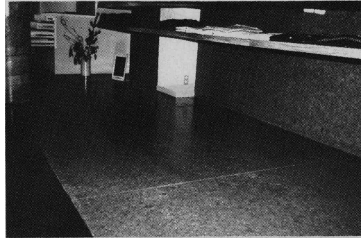
カラマツセメントボードを床と壁に使った例
