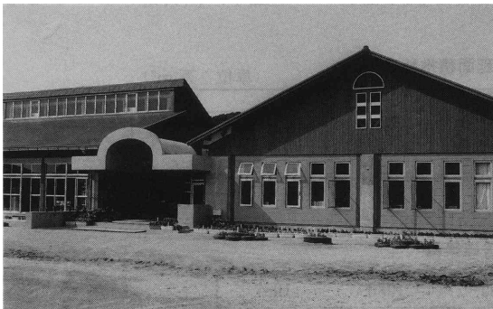
写真1 新築木造校舎（鹿児島県佐多小学校）
